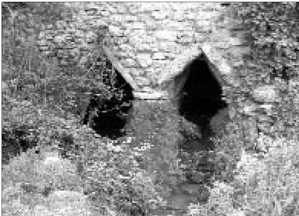
Foto 2: cárcavos del molino de Caminreal
