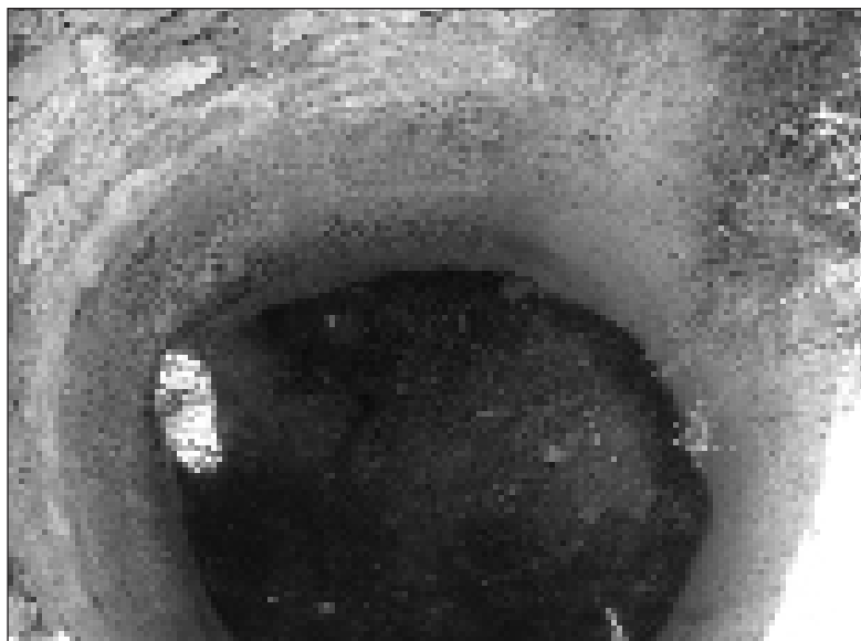
Interior. Calera en La Puentequilla. Cuencabuenana
