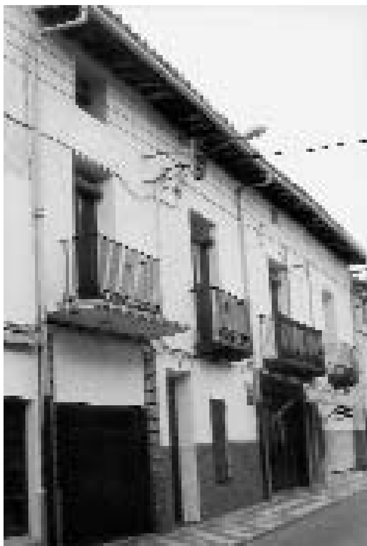
Fachada actual de la casa solariega que ocupaba el Casino Agrícola e Industrial. La planta baja del edificio, en un principio, la ocupaban diferentes dependencias como cuadras, corrales..., posteriormente, se reformó empleándose como bar y baile.
