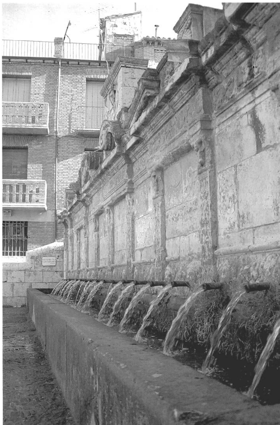
Fuente de los Veinte Caños de Daroca. Construida entre 1639 y 1642.
