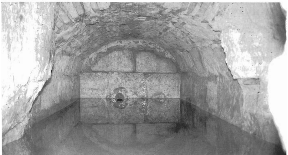
Fuente de Cutanda. Arca de almacenamiento llena.
