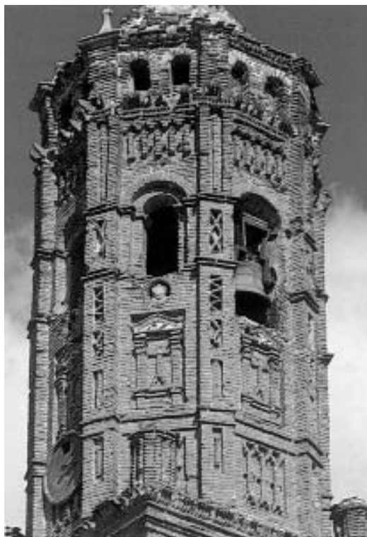
Torre de Navarrete del Río.
