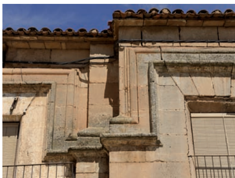
Palacio barroco inconcluso de Used. Detalle del trabajo de cantería. Las viviendas se construyeron aprovechando el muro exterior del palacio, que quedó interrumpido a una altura homogénea correspondiente al cuarto sillar de los doce que habría de tener el fuste de cada una de las pilastras de orden gigante que modulan la fachada.
