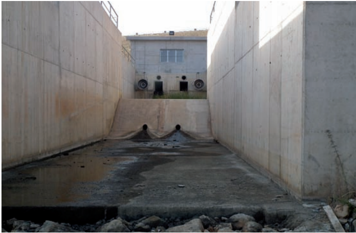
Desagües del pantano de Lechago.
