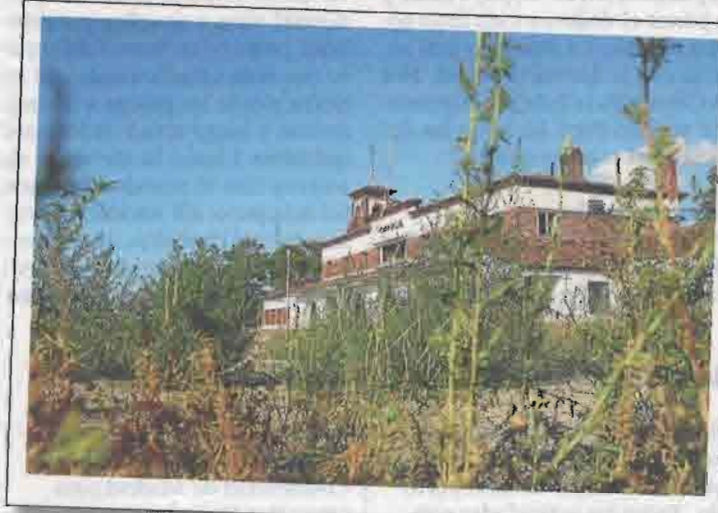
Estación de tren de Caminreal. ANTONIO GARCÍA
